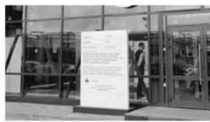
Плохо. Информация, которая должна наноситься на остекление входной группы (при отсутствии глухого простенка), оформлена в виде отдельно стоящей конструкции
