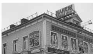
Плохо. Крышная установка в городском пространстве 1-й категории
