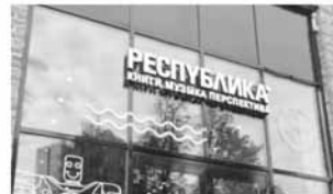
Хорошо. На фасаде над входом нет места для вывески, поэтому она размещена на светопрозрачной конструкции и выполнена из отдельных букв без подложки. При этом вывеска занимает не более 25 % площади остекления.
