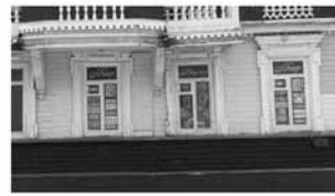
Плохо. Вывески занимают больше 25 % остекления
