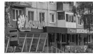
Плохо. Вывеска размещена над козырьком с плоским фризом
