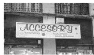
Плохо. Вывеска размещена без учета архитектурных особенностей фасада
