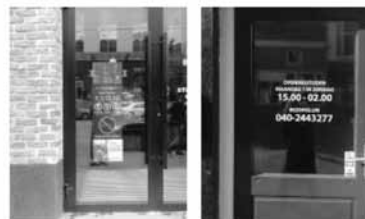
Хорошо. Расстояние от блока информации до переломов остекления по ширине и высоте больше 10 % стеклянного полотна
