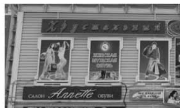
Плохо. Реклама полностью заполняет оконные проемы
