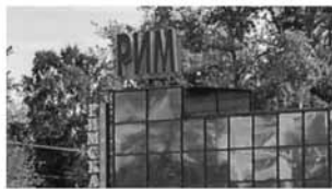
Плохо. Крышная установка с подложкой
