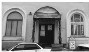
Плохо. Табличка размещена на входной двери, расстояние от нижнего уровня входа меньше 0,8 м
