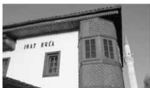
Хорошо. Отсутствие крышной установки на историческом фасаде здания. Вывеска выполнена из отдельных букв без подложки в едином стиле со зданием
