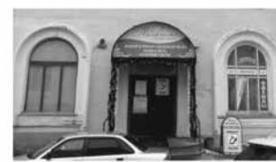
Плохо. Табличка размещена прямо на полотне входной двери на расстоянии менее 0,8 м
